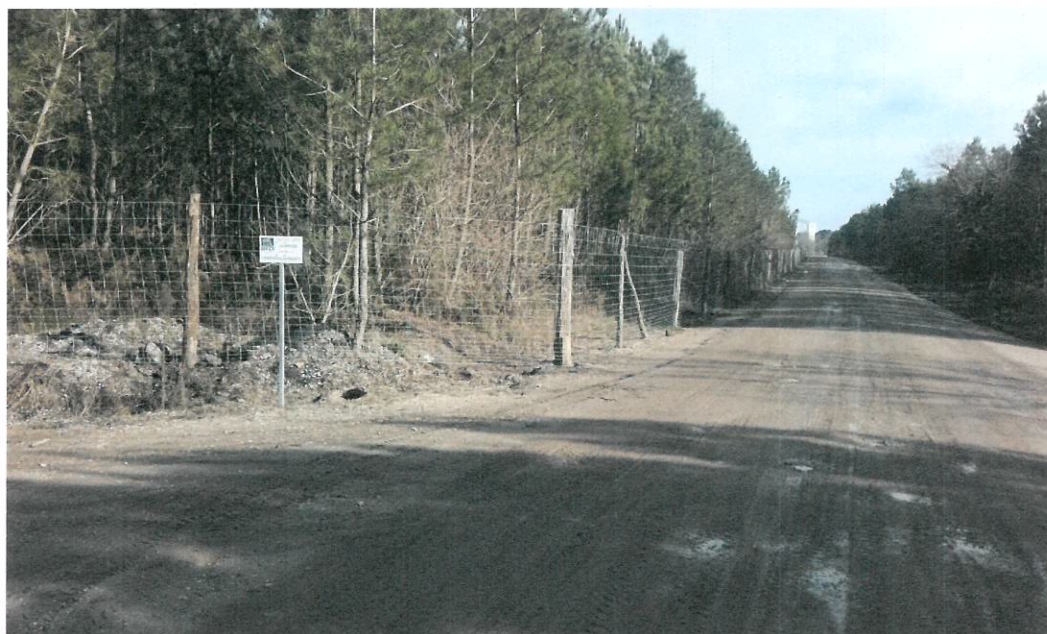
Clôture totale du site
